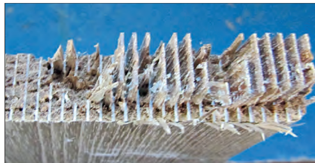
Bruchbild: In unzähligen Prüfungen nach DIN und EN wurden Biege- und Zugfestigkeit sowie das Delaminierungsverhalten gemessen, um die idealen Produktionsparameter zu ermitteln.
